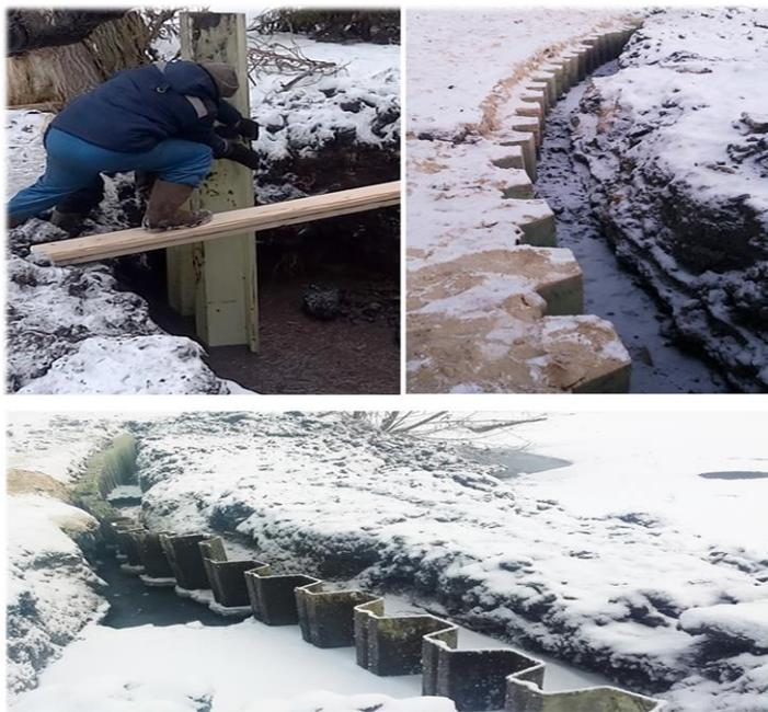
Рис. 6 – Укрепление береговой линии водоема с помощью стеклопластиковых шпунтов корытного типа производства ФГУП «ВИАМ» (ПГТ Языково Корсунского района Ульяновской области)
