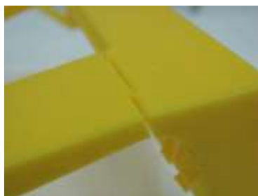
Рис. 1 – Трещины и разрушение
