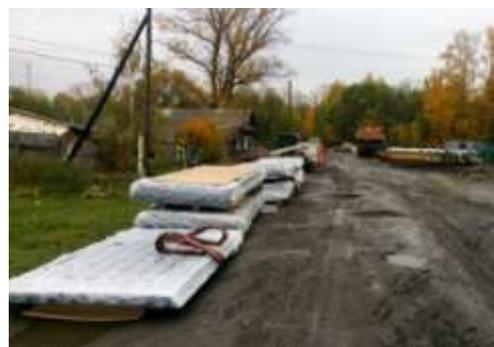
Рис. 4 – Арочные элементы и профилированный настил на строительной площадке
