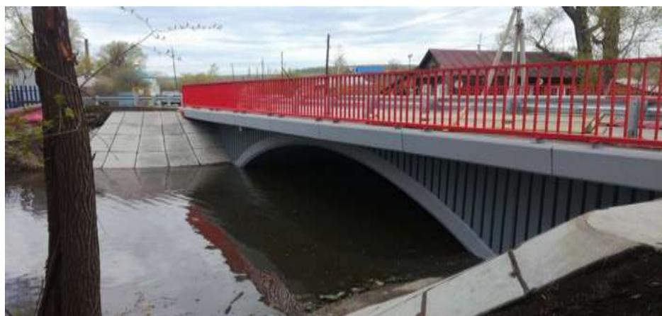
Рис. 5 – Новый мост с силовыми элементами из ПКМ – длина пролета 15 метров
