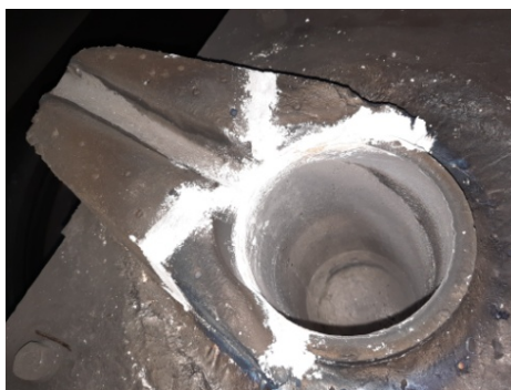
Рис. 5 – Плавильный тигель после ремонта дефектов (трещин)
