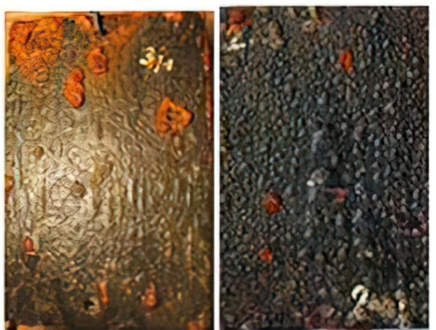
Рис. 1 – Вздутие покрытия и появление ржавчины в результате слабой адгезии эпоксидно-каучукового состава к антикоррозионному слою
