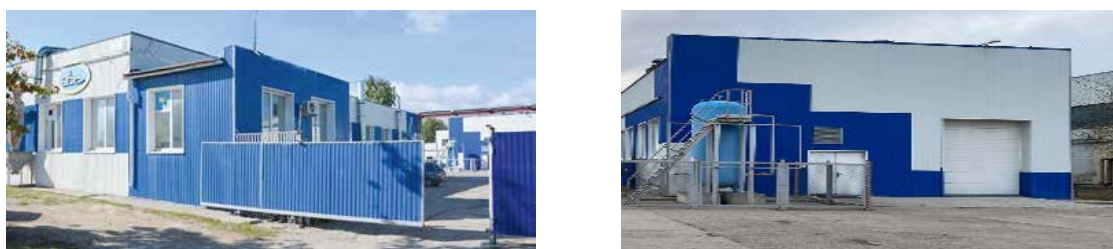
Рис. 3 – Производственная площадка УНТЦ ВИАМ после реконструкции
