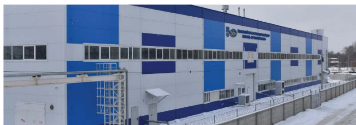
Рис. 20 – Лабораторно-производственный корпус по выпуску полимерных композиционных материалов и покрытий
