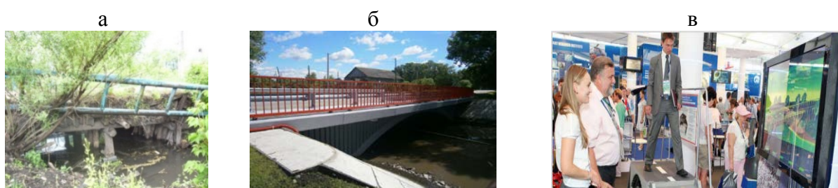
Рис. 4 – Мост в р.п. Языково Ульяновской области: а – мост до реконструкции; б – мост после реконструкции; в – интеллектуальная система контроля движения встроенная в дорожное полотно моста
